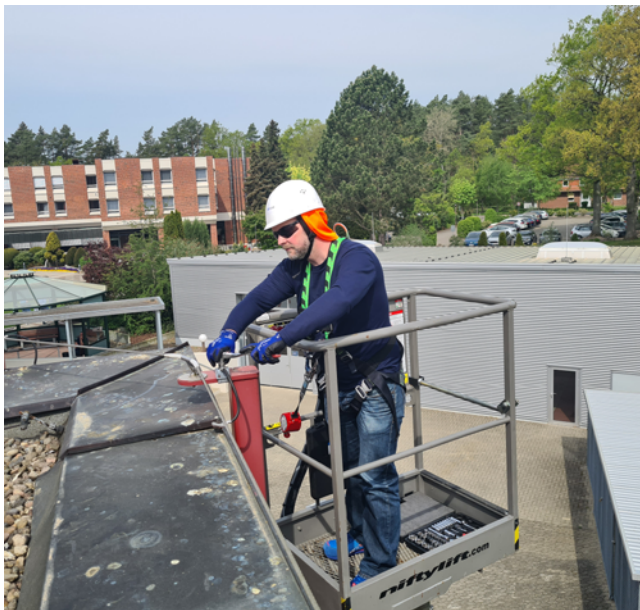
Abb. 18 Sonnenschutz bei Montagearbeiten im Freien
