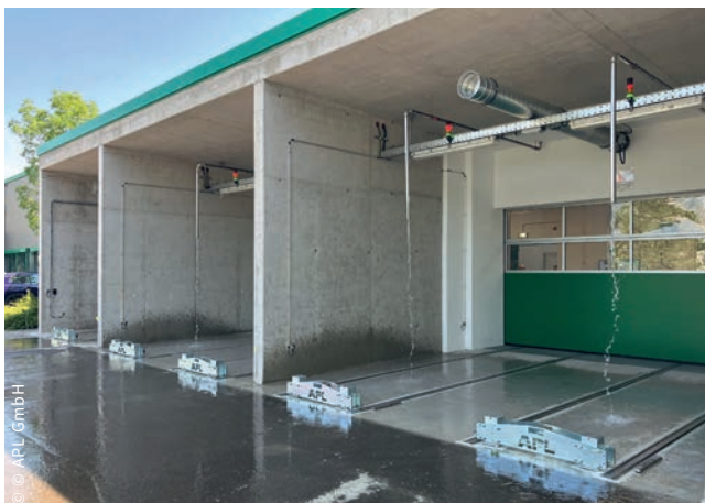
Außenbereich der Batteriebefundung
